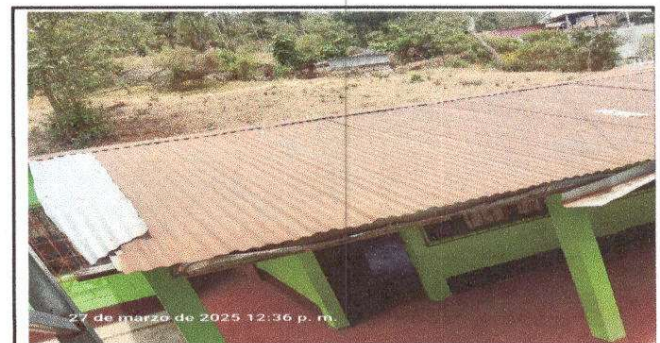
Foto 6: Área canales y bajadas de agua pluvial.
