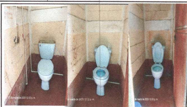
Foto 8 Area donde se colocara el azulejo baños .
